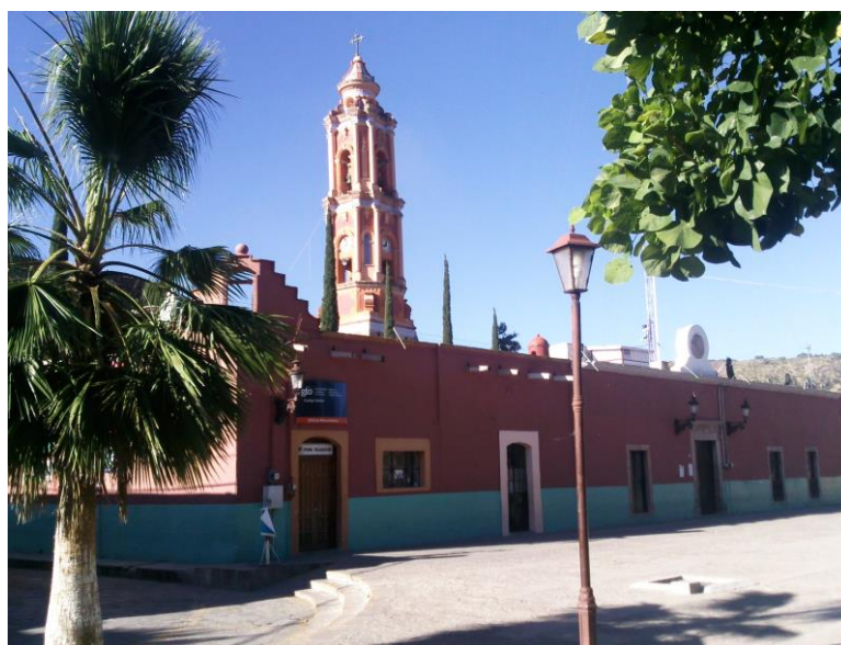
Edificio Presidencia Municipal
