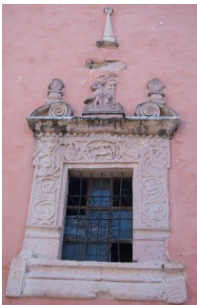
Fachada del bautisterio.
